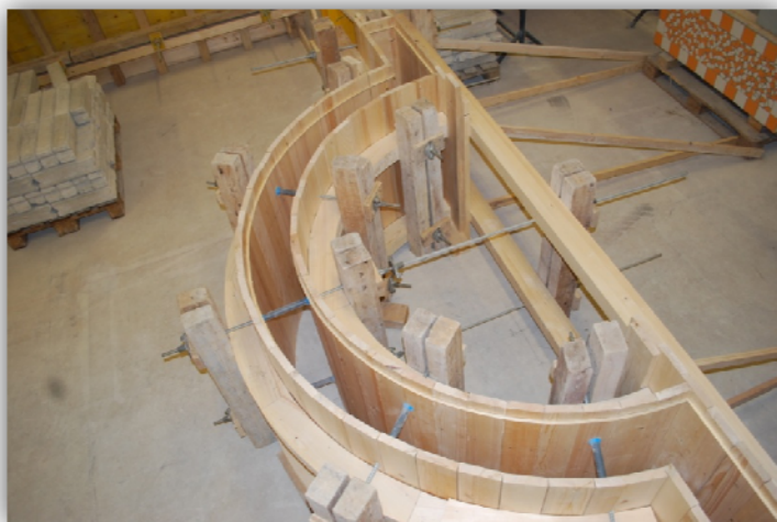
Objet en construction à la halle des maçons (Photo KP)
