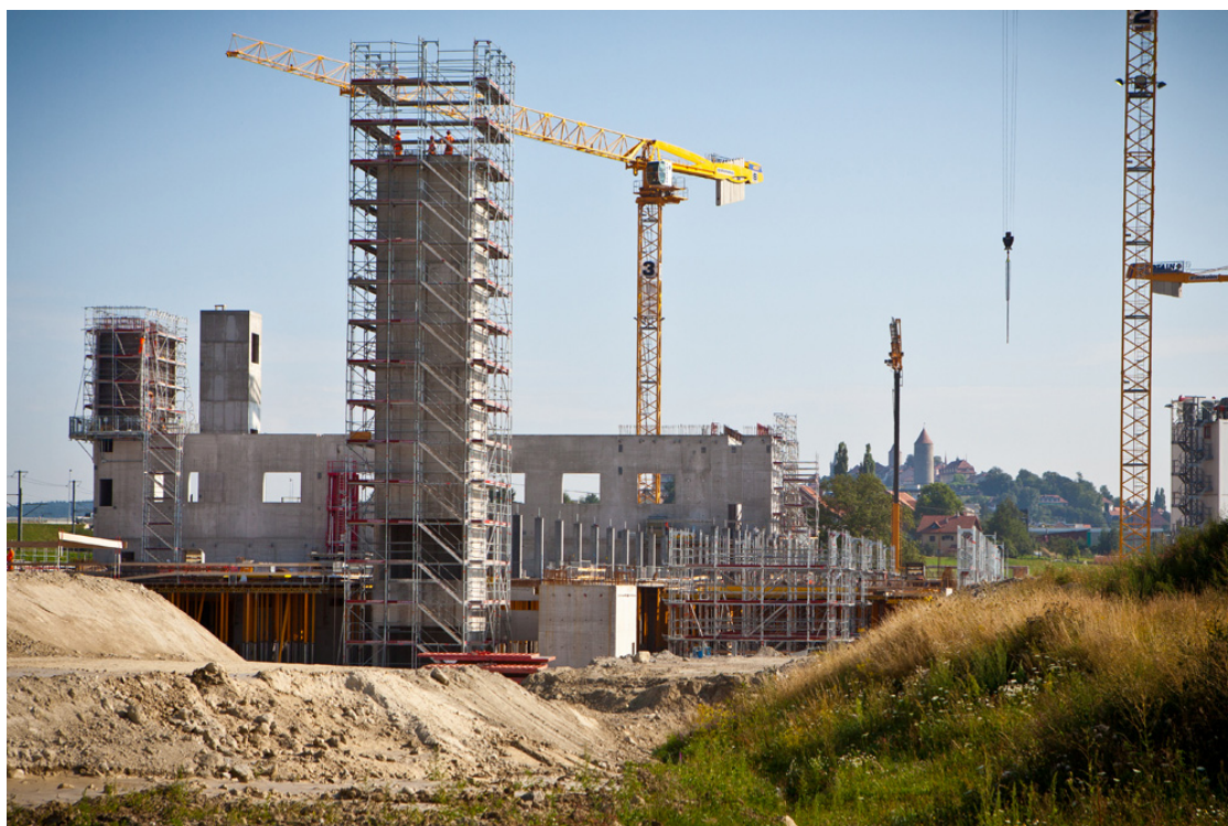
Chantier Nespresso, Romont
