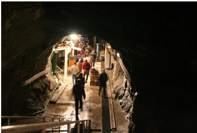
Les entrailles du barrage de la grande Dixence (photo JDW)
