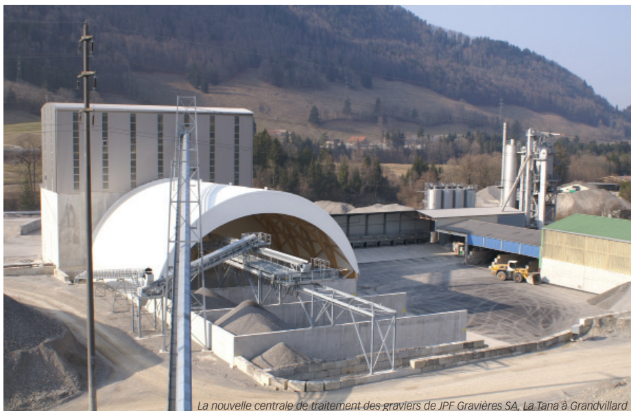
La nouvelle centrale de traitement des graviers de JPF Gravières SA, La Tana à Grandvillard
