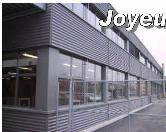
Nouvelle halle des maçons
